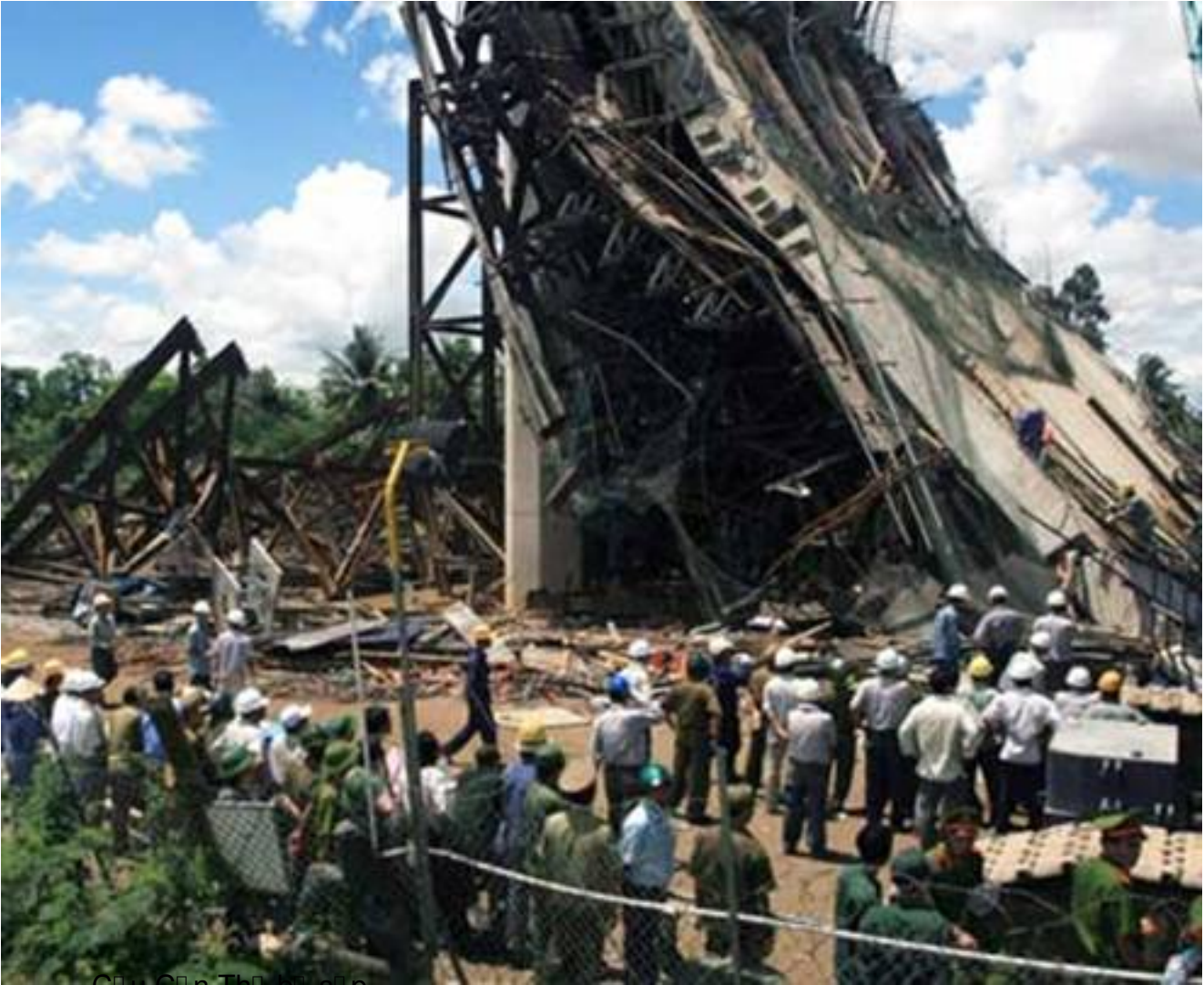
Cầu Cầu Thép bê tông
